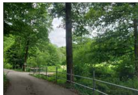
Ziegelofengasse: Ausbesserungsarbeiten am Straßenbelag und den Kanaldeckeln, Anbringung eines Sicherheitsgelanders
