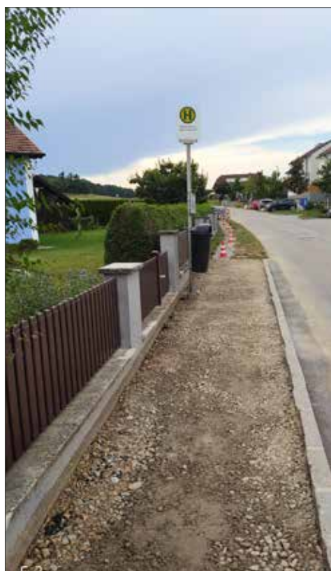
Sandlstraße, Bushaltestelle Josef-Lechner-Straße: Sanierung im Wartebereich.
