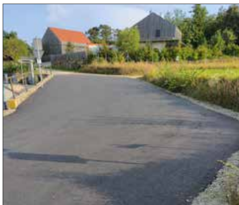
Dr.-Max-Thorwesten-Straße: Sanierung des Straßenbelages
