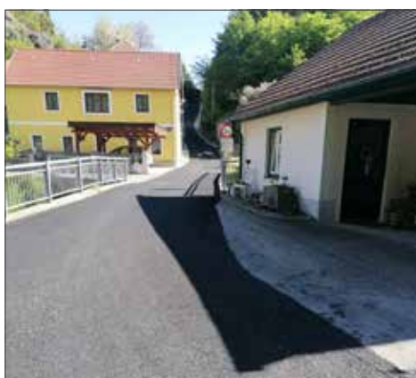
Spiegelweg: Sanierung des Straßenbelages
