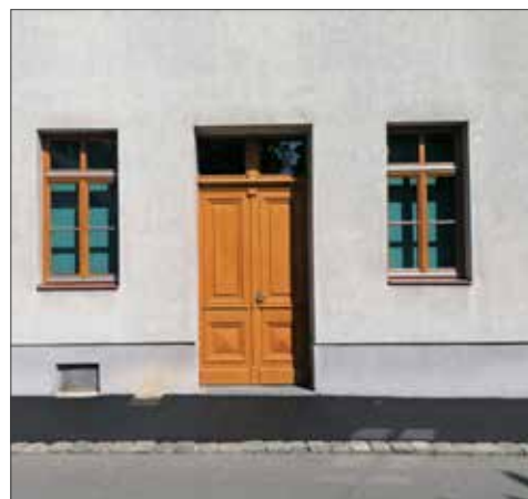
Schulstraße: Gehsteigsanierung vor der Volksschule Egelsee
